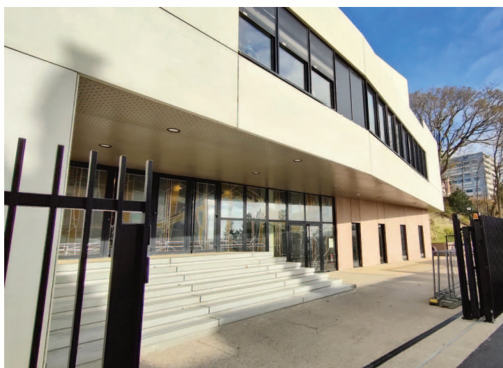
Septembre 2021 : une rentrée dans un lycée flambant neuf.
