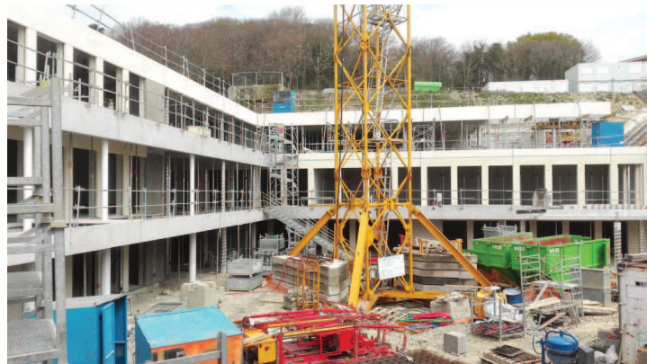
Au cœur du chantier, les contours du futur lycée se dessinent
